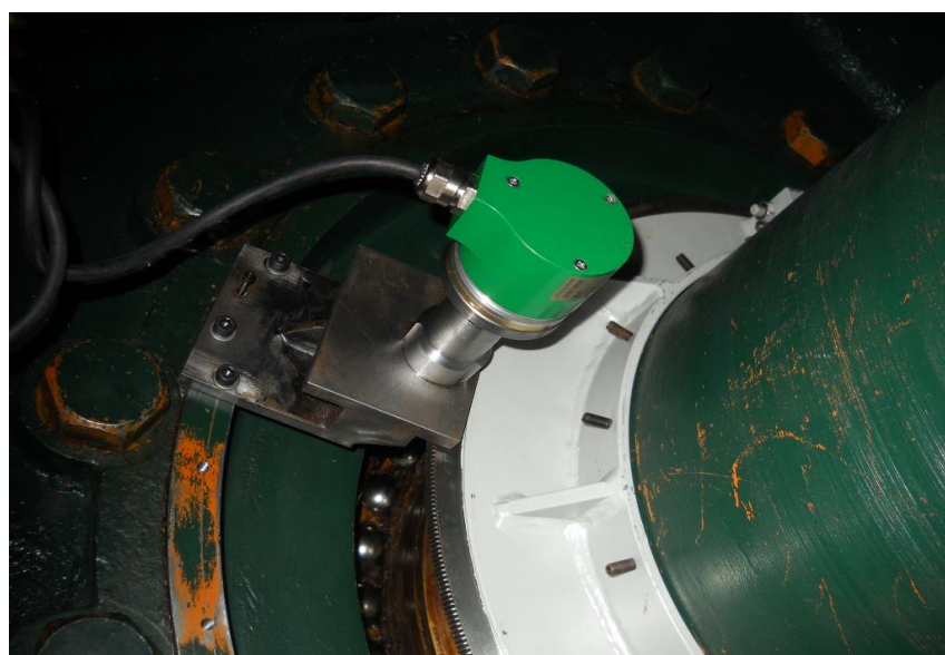
Fig. 9: Il nuovo encoder delta collocato all'interno del cubo.
